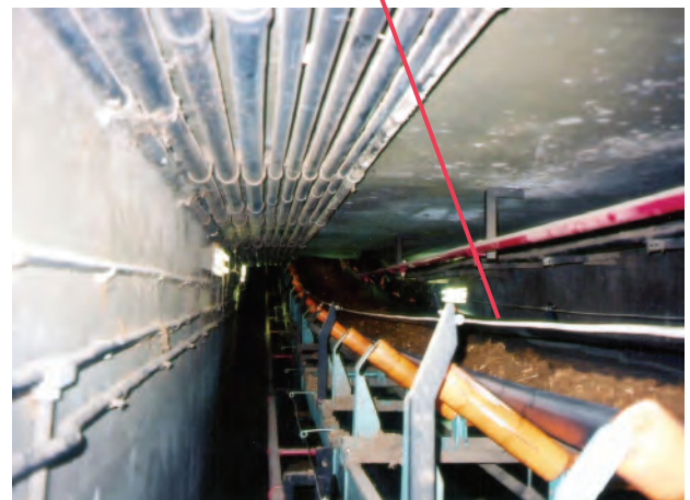
Protectowire Linear Heat Detector
